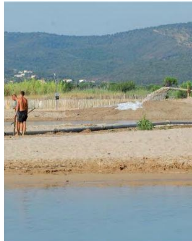
Menés dans le cadre d'un contrat marin Natura 2000, les travaux de désensablement de l'embouchure de l'Argens ont permis d'extraire quelque 1500 m 3 de sable et sédiments pour fluidifier à nouveau la passe vers la mer...
