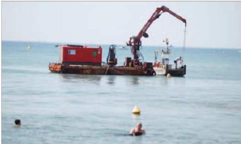
L'objectif : créer un chenal de 5 à 10 mètres de large sur une profondeur d'un à deux mètres, afin que l'embouchure du fleuve reste ouverte.
