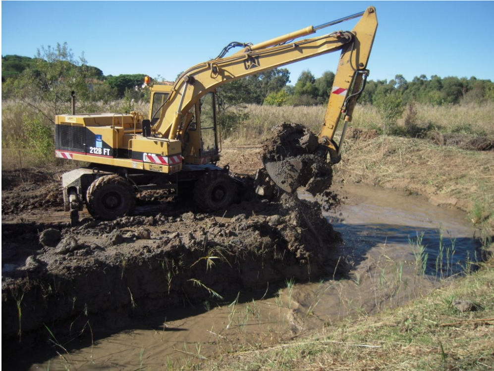
Creusement de la mare par la pelle mécanique
