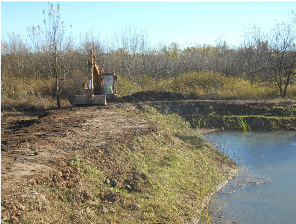
Mise en forme de la butte autour de la mare
