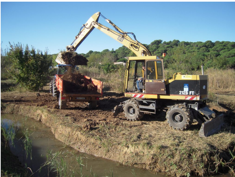
Creusement de la mare par la pelle mécanique et évacuation de la terre pour la création de la butte
